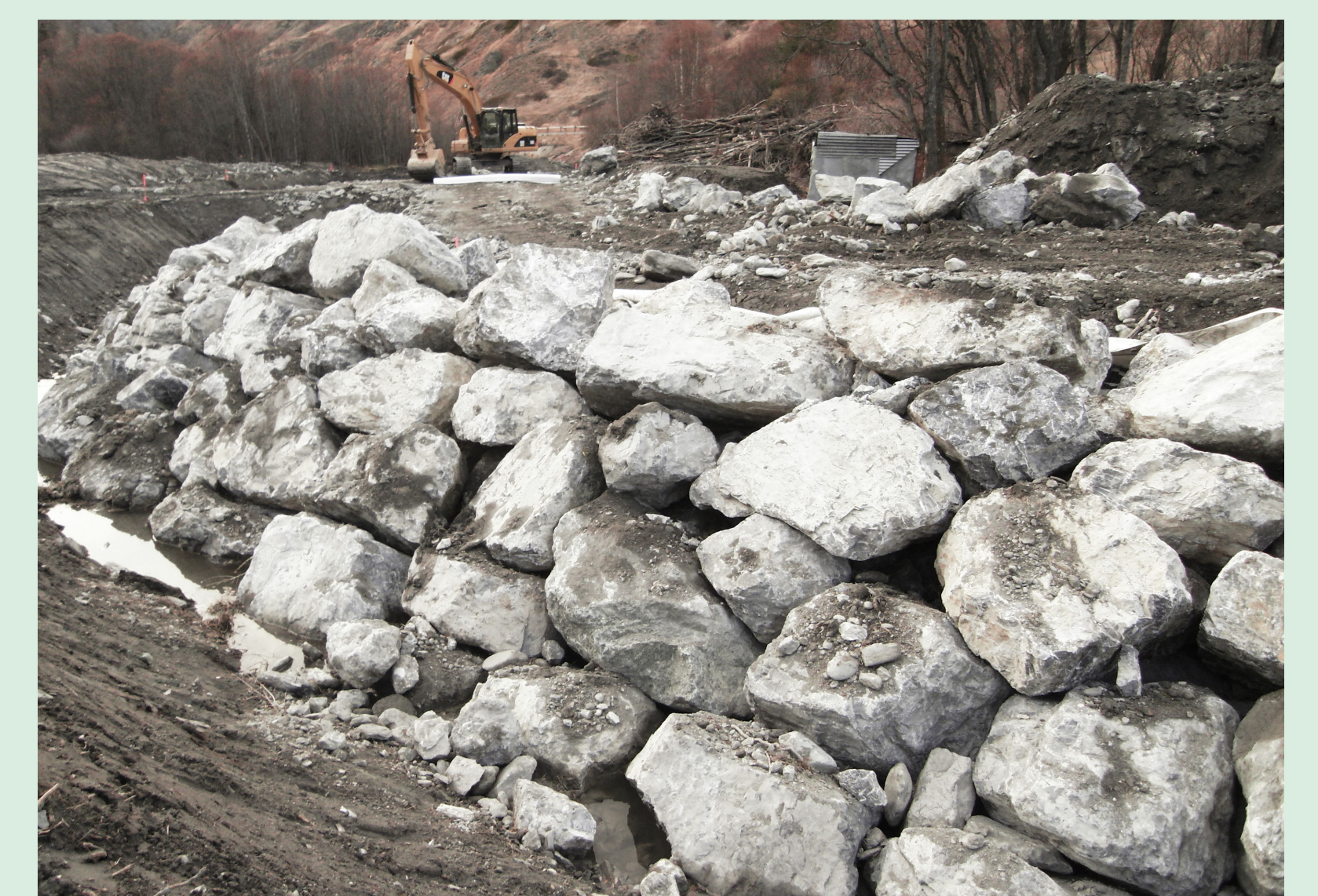
Perré de protection à ABRIES
