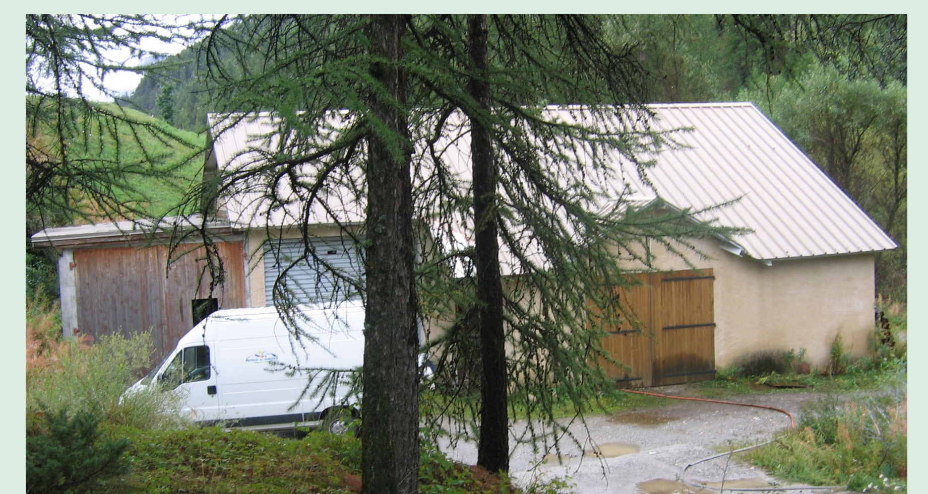
Station d'épuration d'ARVIEUX
